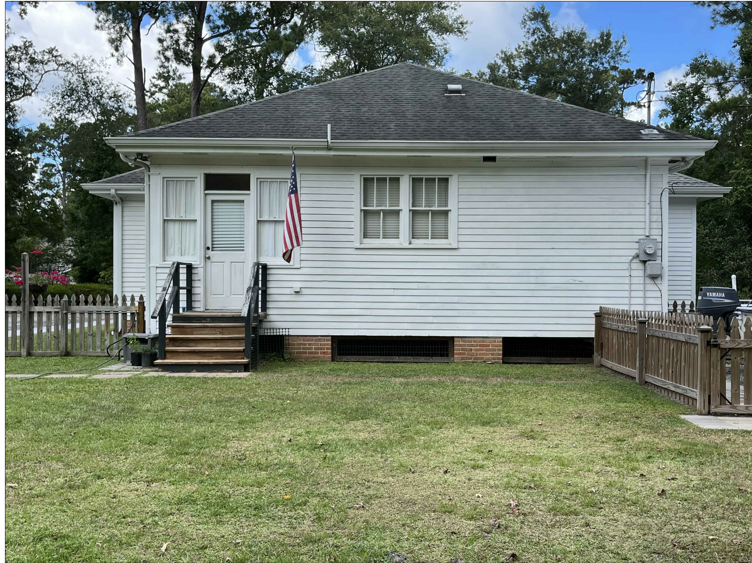
1 EXISTING REAR VIEW N.T.S.
